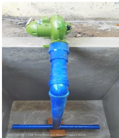
Gambar 5. Pemasangan Blower di Bak ke-2
