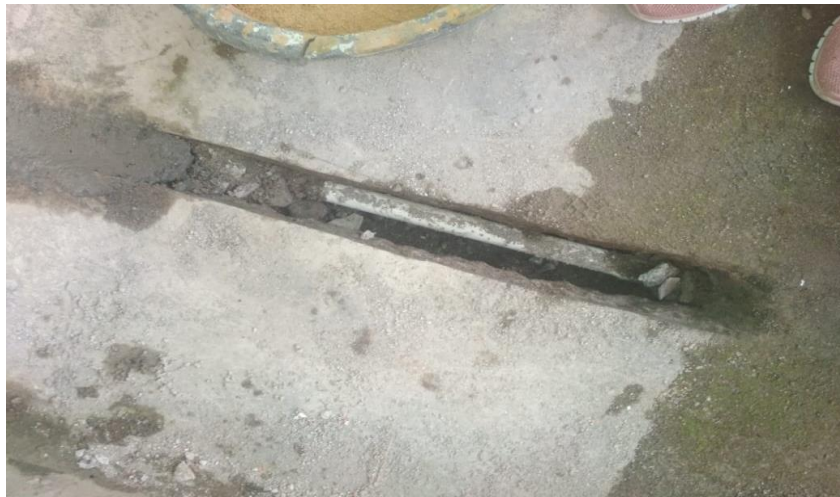
Gambar 2. Pemasangan Instalasi Pipa
